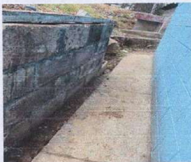
Foto 2: Reparación de Muro de Contención
