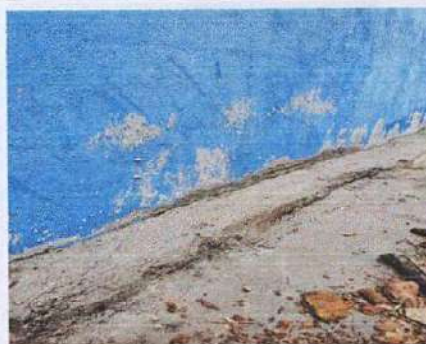
Foto 6: Reparación de cuneta de concreto en exterior de aula
