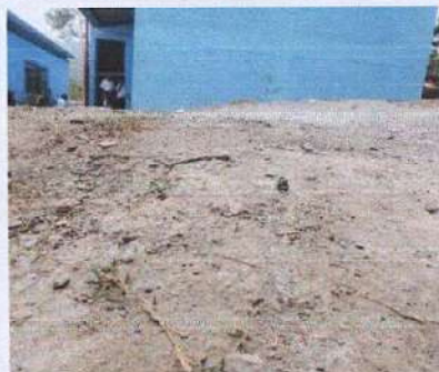
Foto 4: Mantenimiento de losa de patio
