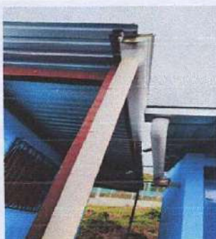
Foto 3: Cambio de Canal y bajadas de agua pluvial
