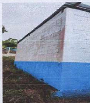
Foto 5: aplicación de pintura exterior e interior
