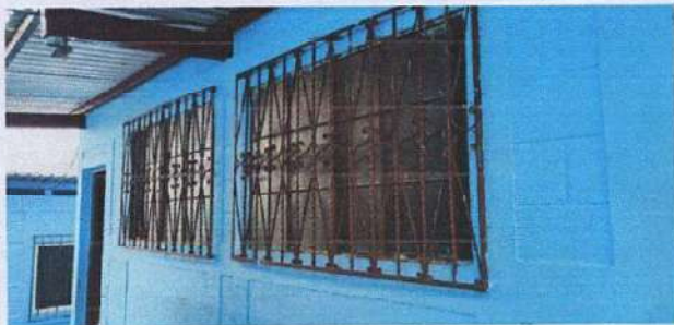
Foto 1: Cambio de ventanas y mantenimiento de balcones
