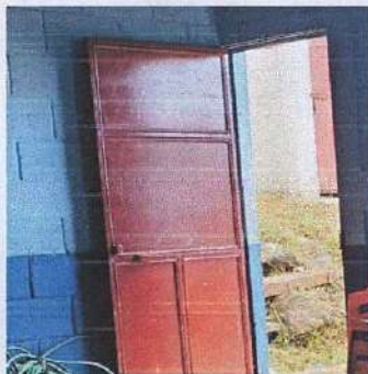
Foto 7: Mantenimiento y reparación de puertas (chapas y pintura).
