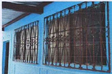
Foto 8: Mantenimiento de balcones
